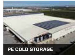
PE COLD STORAGE
